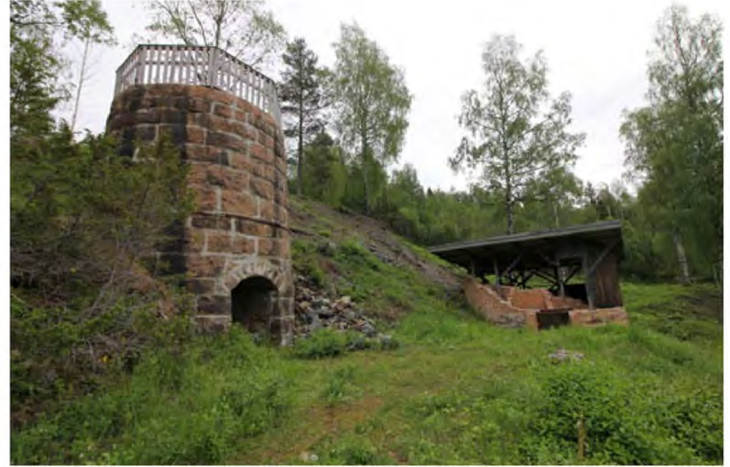
Direktør Borchgrevincks ovn fra 1908. Ovnene er bygd i granitt og foret med ildfast teglstein. Ovnene ble delvis restaurert i 1991.
