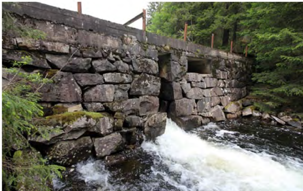
Demning (post 6) for magasinering i dammen Storfløyta over Bolchen tresliberi.
