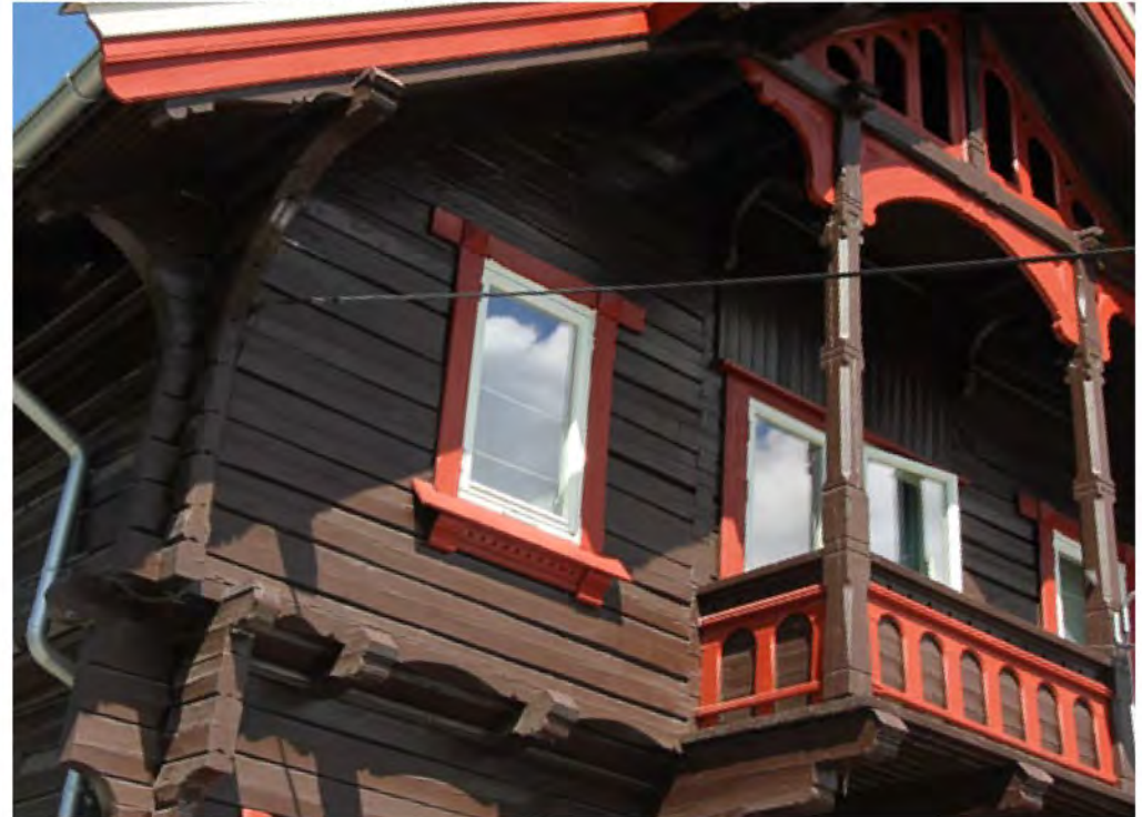
Bygningsdetaljer i dragestil på stasjonsbygningen.
