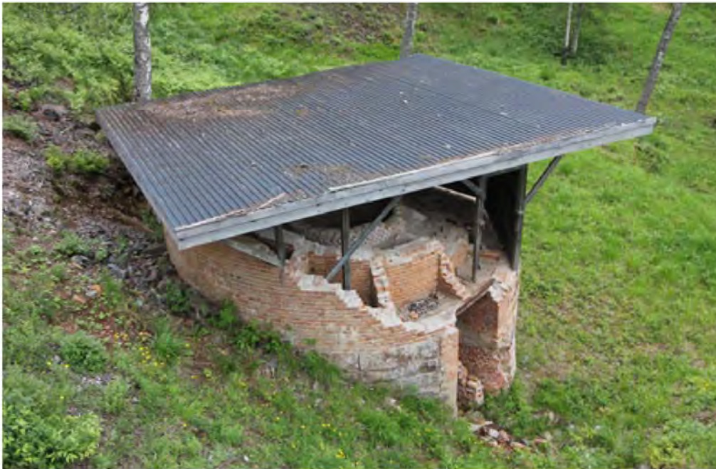
Nedre del av Emil Kristoffersens ovn fra 1912. Slik den står i dag ser vi tydelig "termosprinsippet" med kammer mellom en indre og en ytre vegg. Dette var et fremskritt for å heve energieffektiviteten - kalk må brennes på temperaturer over 850 grader Celcius. Denne ovnen ble gravd frem og fikk et tak til beskyttelse i 1991.
