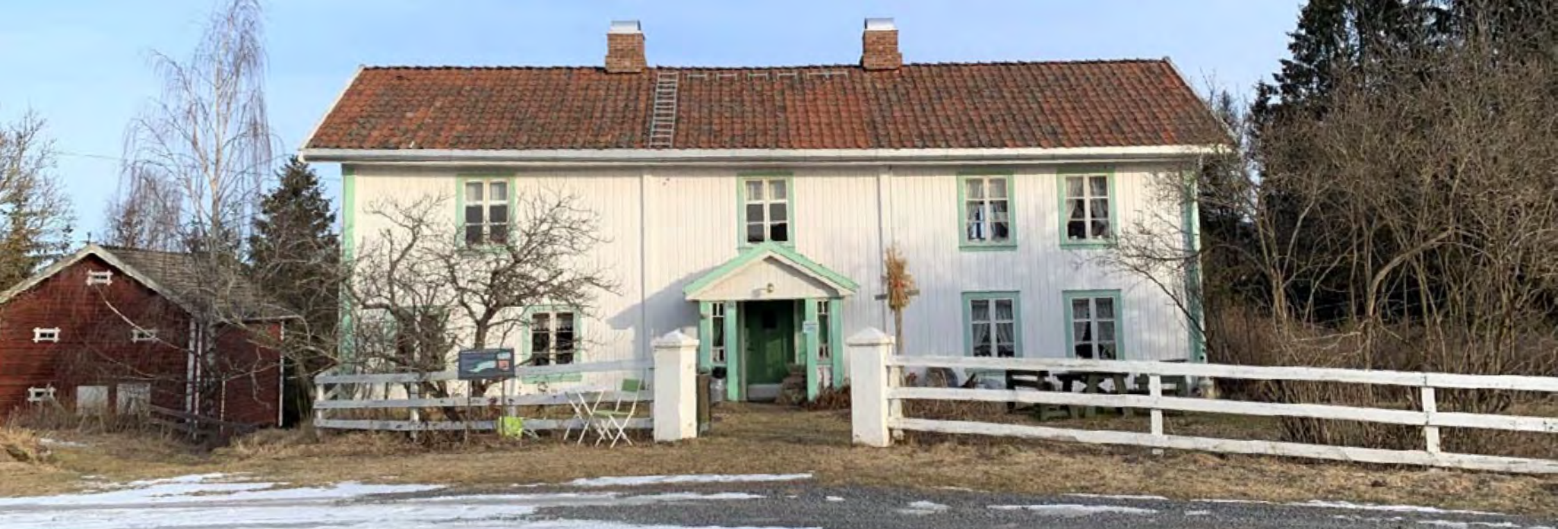
Gamlebygningen på Øvre Vestern, sørfasaden (foto Siri Heier).
