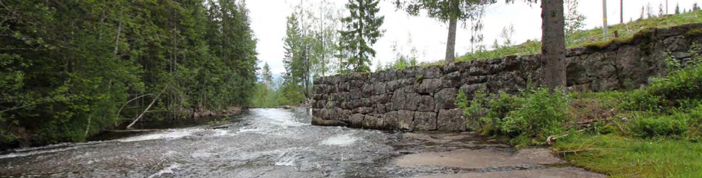
Grunnmuren til fabrikkbygningen på Bolchen Træsliperi (post 3).
