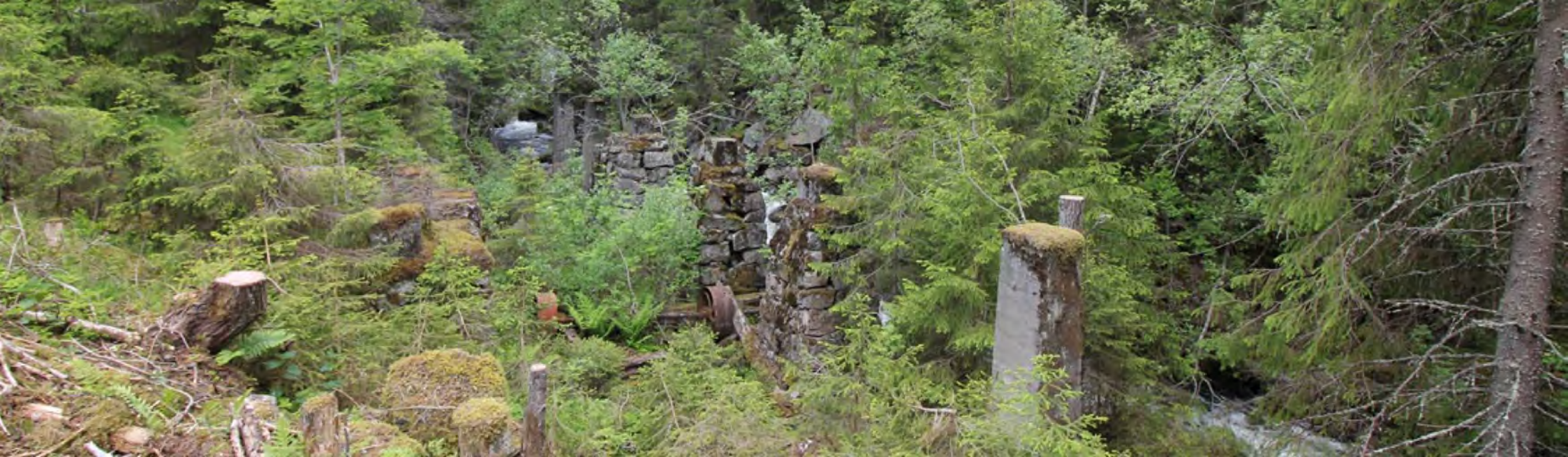
Grunnpilarer etter sagbruket ved Myllselven træsliberi/Lunner Tremassefabrikk (post 7).
