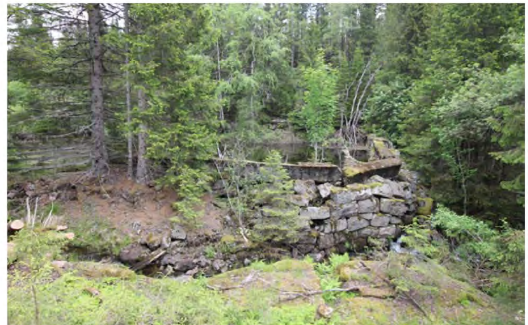
Demning for magasinering over Myllselven træsliberi/Lunner Tremassefabrikk (post 7)
