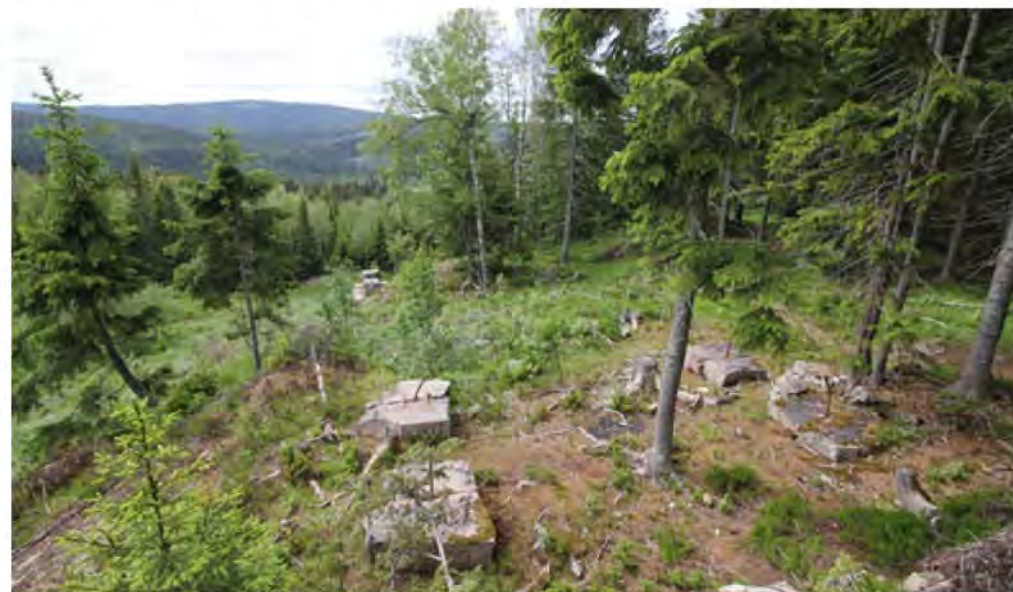
Betongfundamenter til støttene for taubanen fra gruveområdet ned til vaskeriet.
